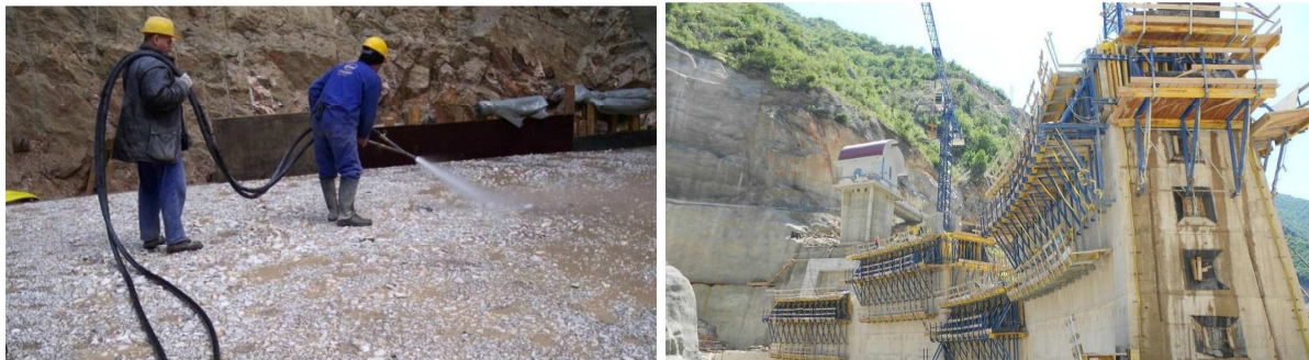
Slika 8: Brana "Sv.Patka", Veza između horizontalnih i vertikalnih betonskih blokova
