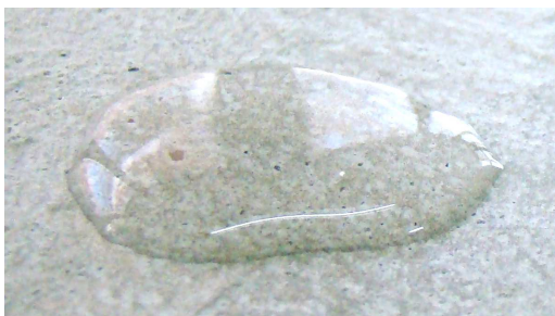
Slika 3: Vodo-repelentna betonska površina
