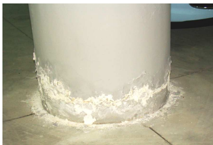
Slika 2: Efekt kapilane apsorpcije vode u betonu
